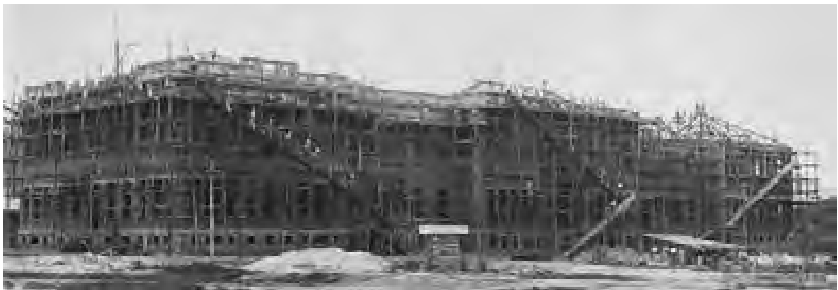
Figura 1 – Edifício principal da UFV em construção – Década de 1920
